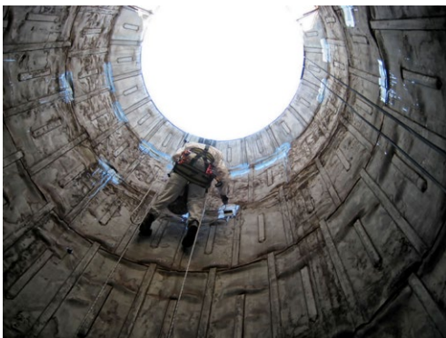
HKW Lichterfelde, Instandsetzung Rauchgasröhre
