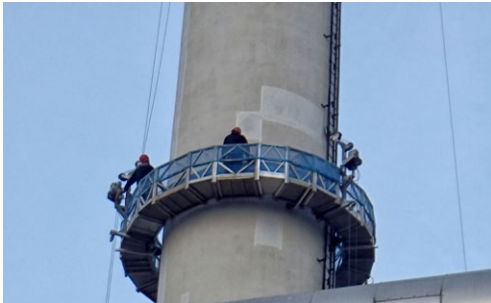
AVG Hamburg, Stahlbetonsanierung
