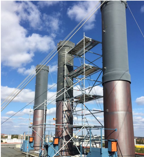
BSR Berlin, Inspektion Stahlabluftkamine
