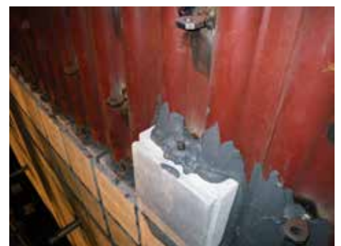
JuSyS® CFB Montage des Plattensystems
